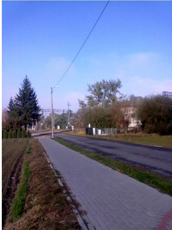
Ryc. 9 Fragment linii energetycznej nn zmodernizowany i wykonany jako bezpieczna linia izolowana
